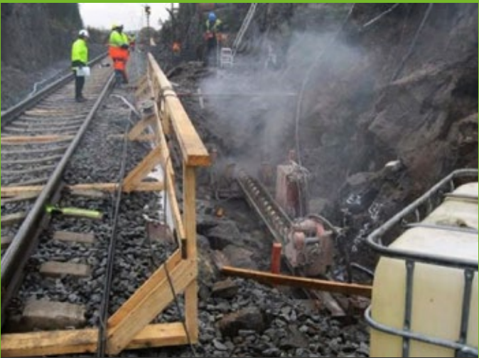
ТРУБОПРОВОД В КРЕПКОЙ ПОРОДЕ, ПРОБУРЕНО 6 СКВАЖИН ПО 70 М.
