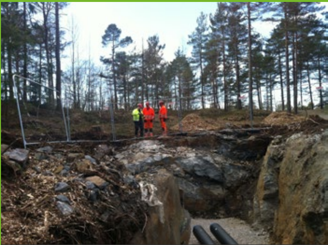
ТРУБОПРОВОД | Ø 650 mm rockhole
