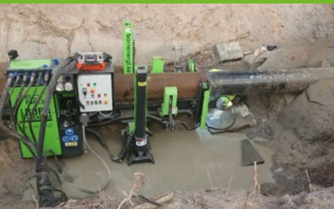
Город Örebro, Швеция. Дdiam. бурения 406,4 мм
