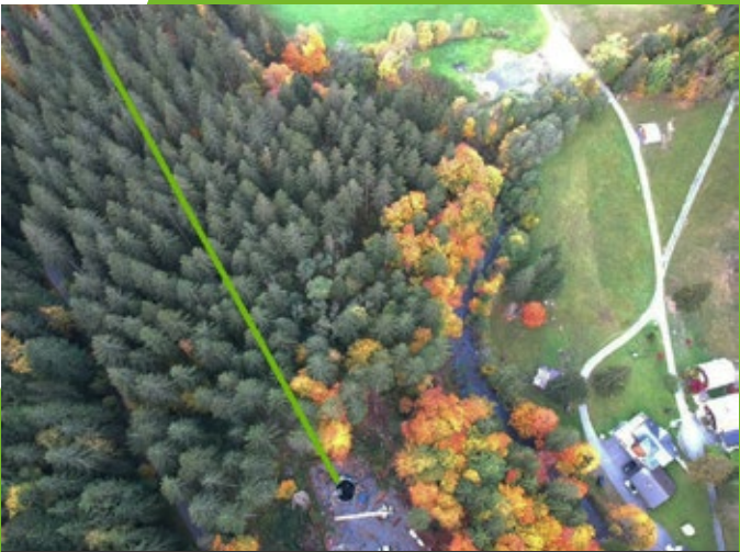
ТРУБОПРОВОД | Ø 406 mm
