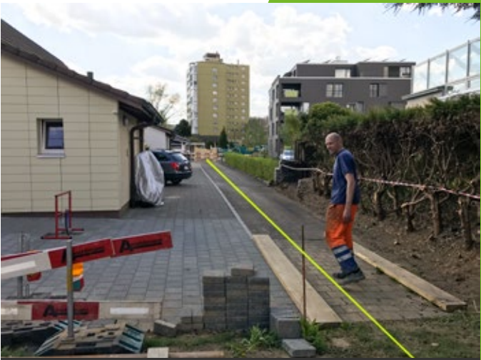
ТРУБОПРОВОД | Ø 323,9 mm
