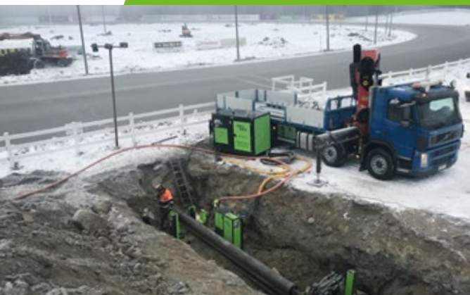
Город Куорю, Финляндия. Дdiam. бурения 323,9 мм
